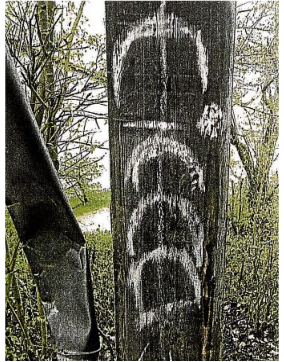
Auch ein Regenrohr wurde zerstört, der Stamm beschmiert.
