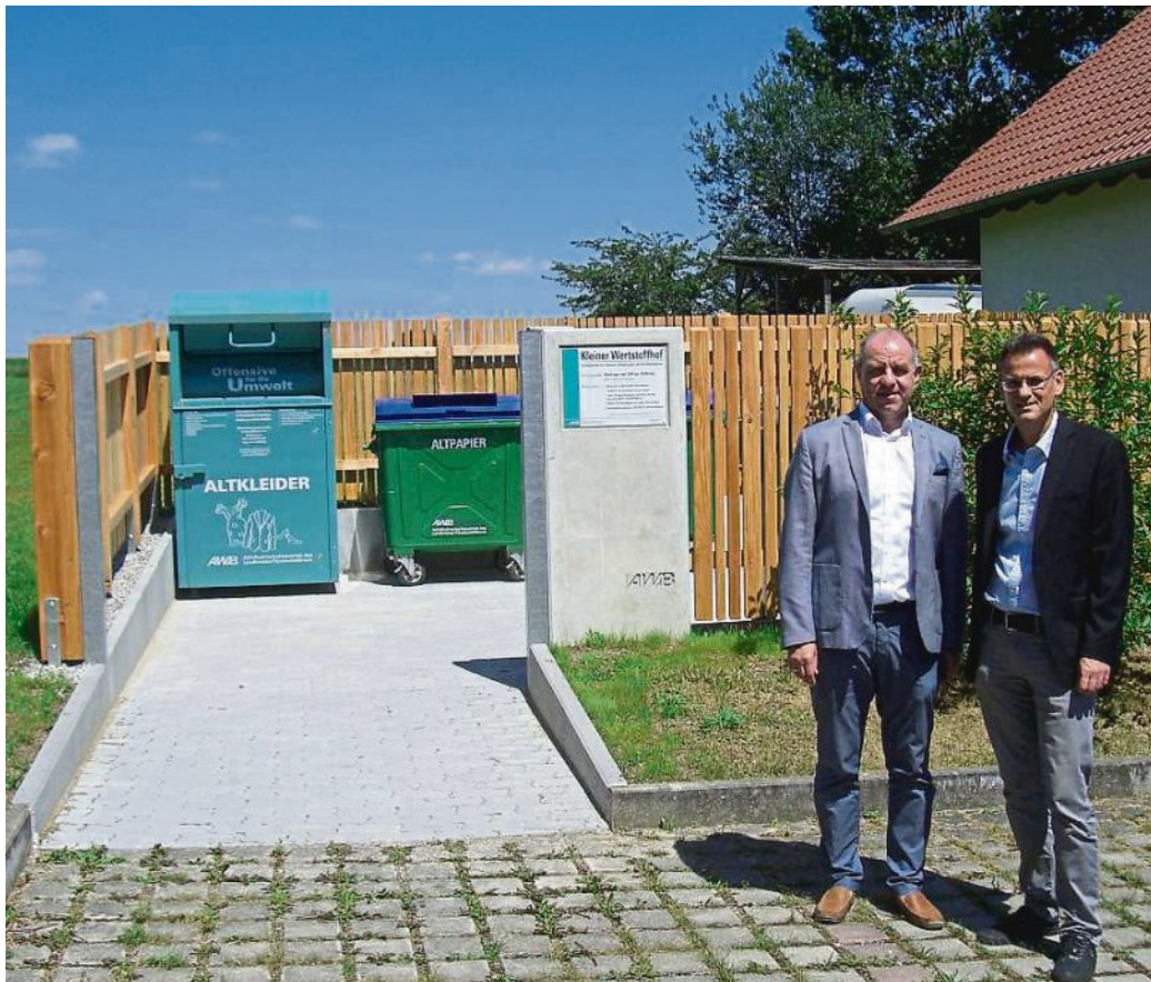
Bürgermeister Joseph Schäffler (li.) und kommissarischer Werkleiter des AWB Stefan Mayer (re.) freuen sich über den neuen Wertstoffhof in Grunertshofen. FOTO: AWB FÜRSTENFELDBRUCK
