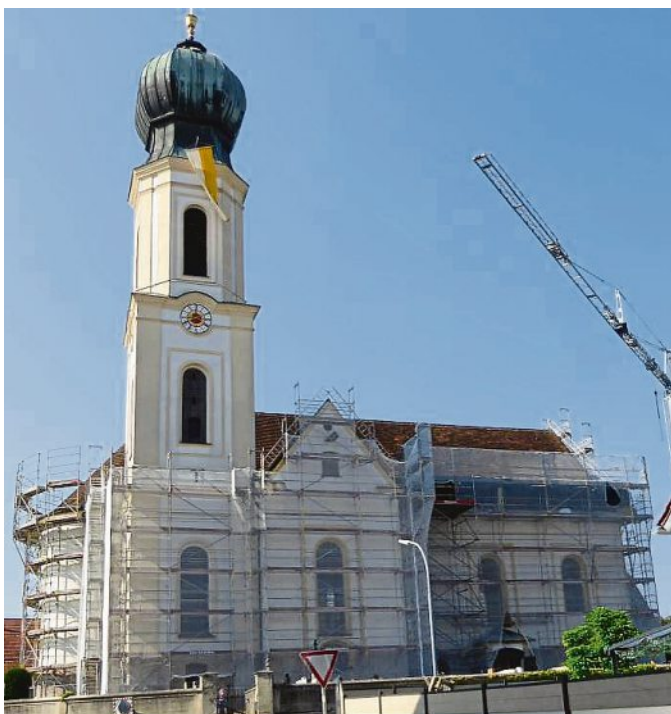
Von außen weithin sichtbar: Die Baumaßnahmen an St. Sixtus.
