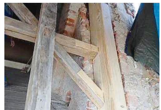
... Balken für Balken ausgebessert
