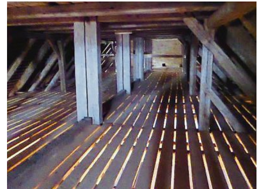
... und die Arbeiten zur Absturzsicherung durchgeführt
