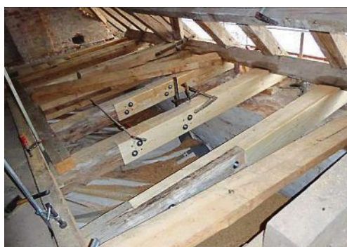
Sowohl mit Holz wird renoviert...
