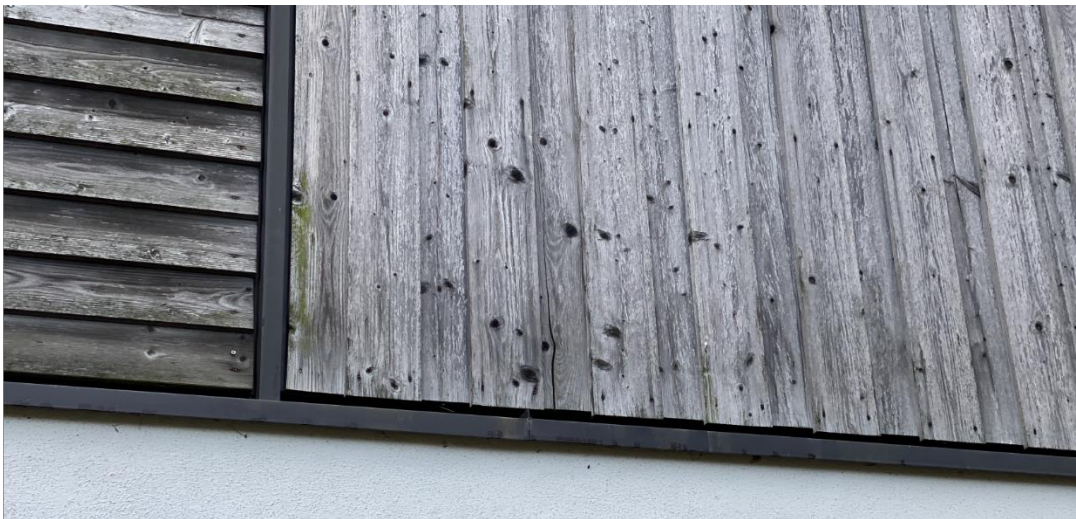
Abbildung 13: Spalten an Holzfassade als Zugang zum Dachboden
